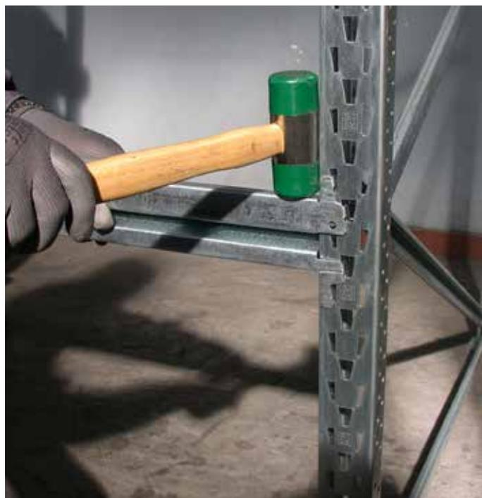
Fissare il corrente con il perno di arresto.
